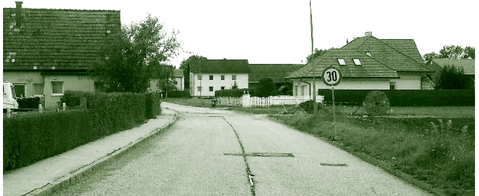
Kurz vor Beginn der Bauarbeiten sah die Humerstraße so aus:
