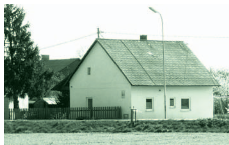
Wächterhaus Nr. 5, Neubau
